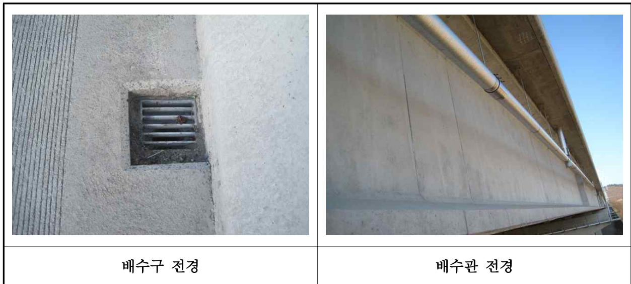
【사진 4.3.21】 배수시설 전경
