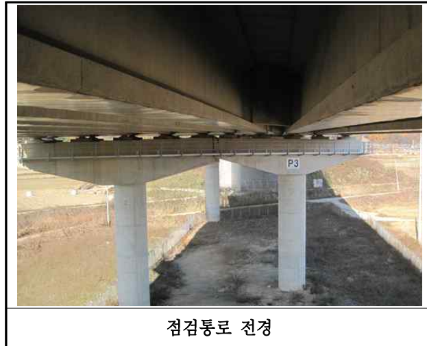
【사진 4.3.25】 교량 점검시설 전경
