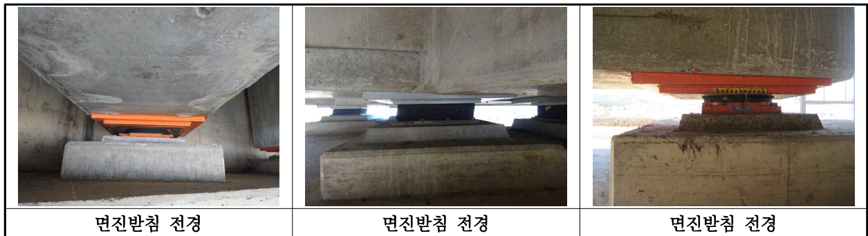
【사진 4.3.12】 교량받침 전경
