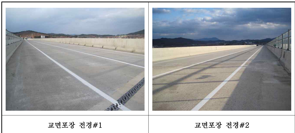
【사진 4.3.45】 교면포장 전경
