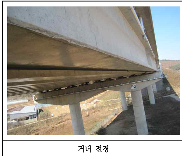
【사진 4.3.4】 거더 전경
