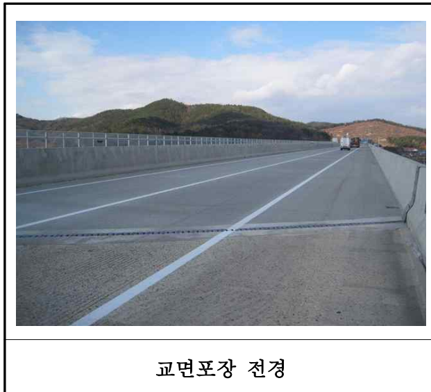
【사진 4.3.19】 교면포장 전경
