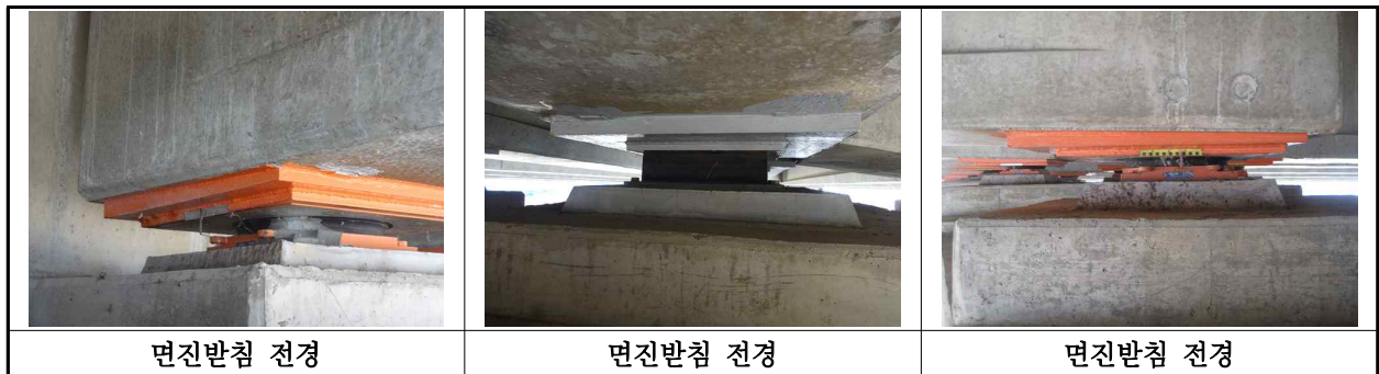
【사진 4.3.37】 교량받침 전경
