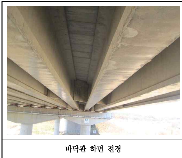
【사진 4.3.2】 바닥판하면 전경
