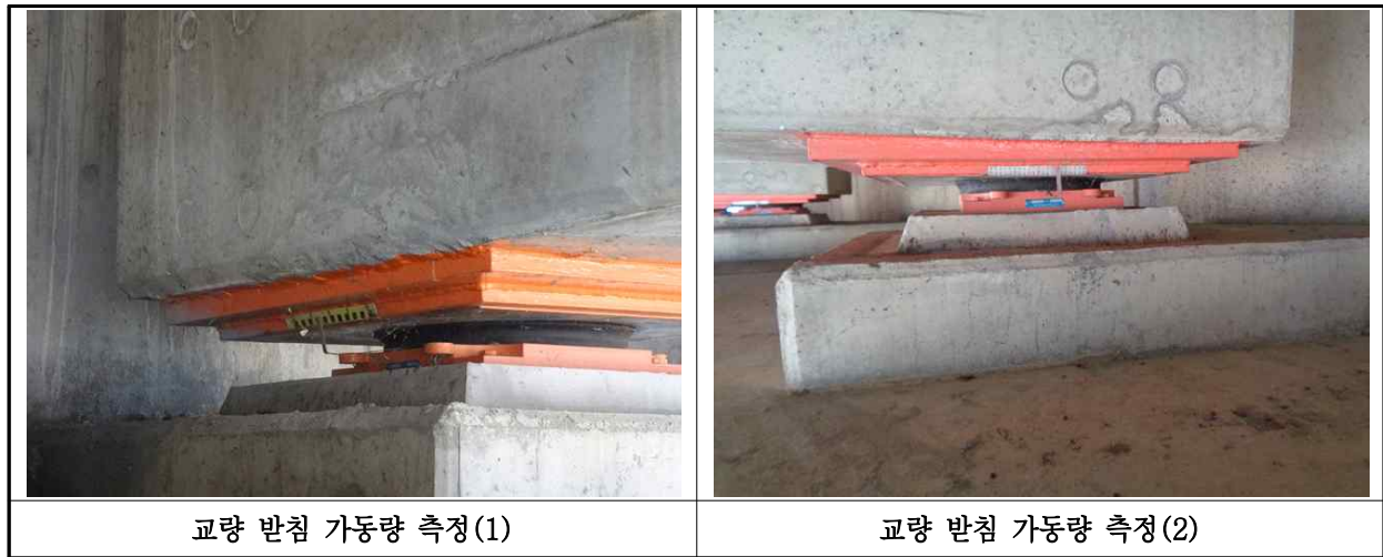
【사진 4.3.15】 교량받침 이동량 측정
