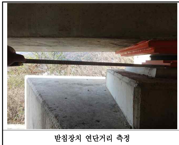
【사진 4.3.40】 교량받침장치 연단거리측정
