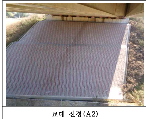
교대 전경 (A2)
