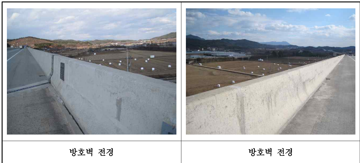
【사진 4.3.23】 방호벽 및 중앙분리대 전경
