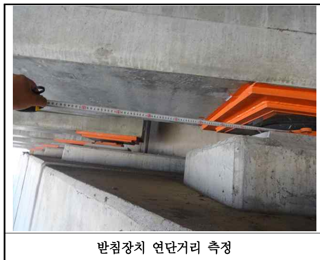
【사진 4.3.14】 교량받침장치 연단거리측정
