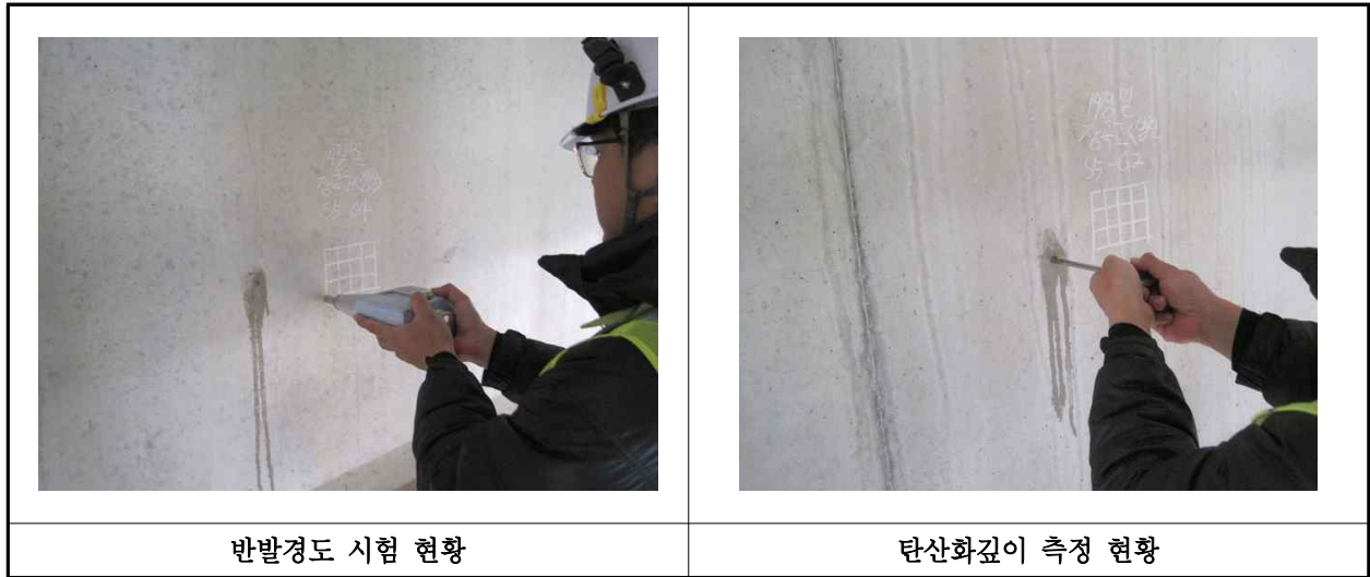
【사진 4.4.1】 콘크리트 내구성조사 현황
