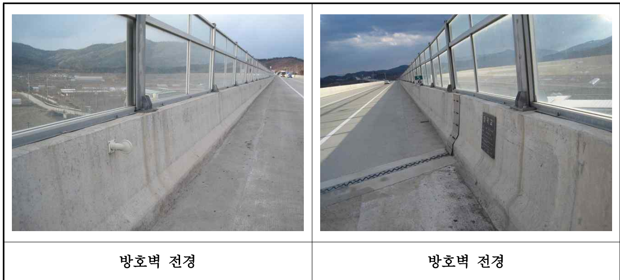
【사진 4.3.49】 방호벽 및 중앙분리대 전경
